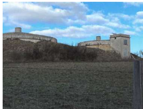
Réservoirs de 650 m 3 et 210 m 3
